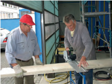
Erich Biebel und Hermann Keßler schneiden über 60 Bretter individuell zurecht, um die drei Gruben abdecken zu können.
