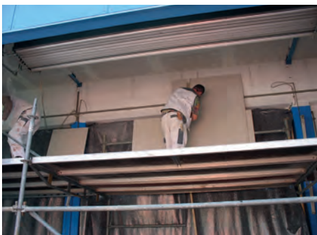
Die Baumaßnahmen für die Brandschutzdecke in der Fahrzeughalle konnten endlich in Auftrag gegeben und im Herbst 2012 durchgeführt werden.
