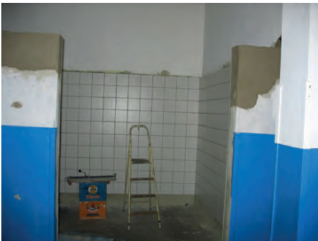
Der ehemalige stark verschmutzte Teilwaschplatz ist auf dem besten Weg, ein hygienischer Taucherwaschraum zu werden.
