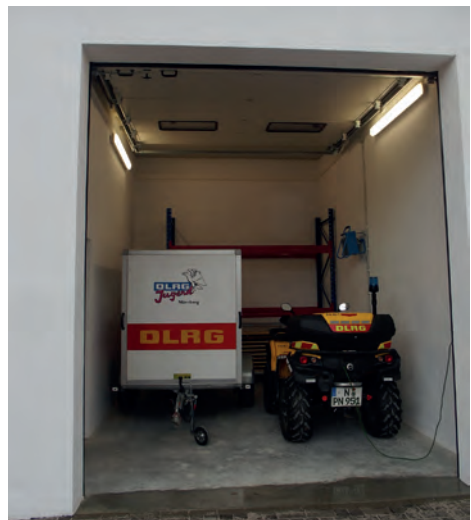
Blick in eine der beiden Doppelgaragen nach Fertigstellung.
