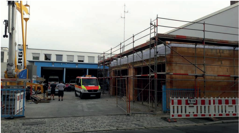
Der Rohbau steht weitestgehend.
