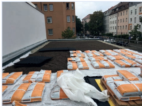
In Schichten wird das Gründach aufgebracht.
