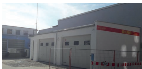
Blick von der Straße auf die neuen Garagen.
