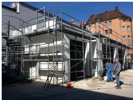
Dank fleißiger Helfer erhalten die Außenfasaden der Garagen einen ersten Anstrich.
