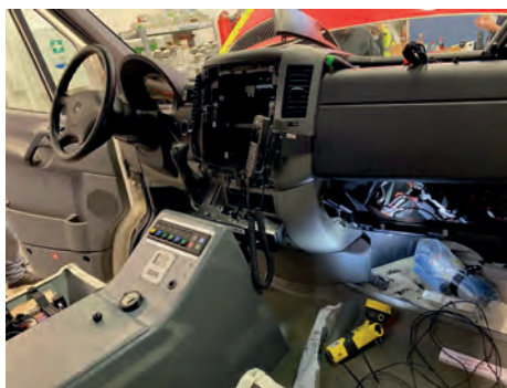
Elektronikausbau unter dem Armaturenbrett.
